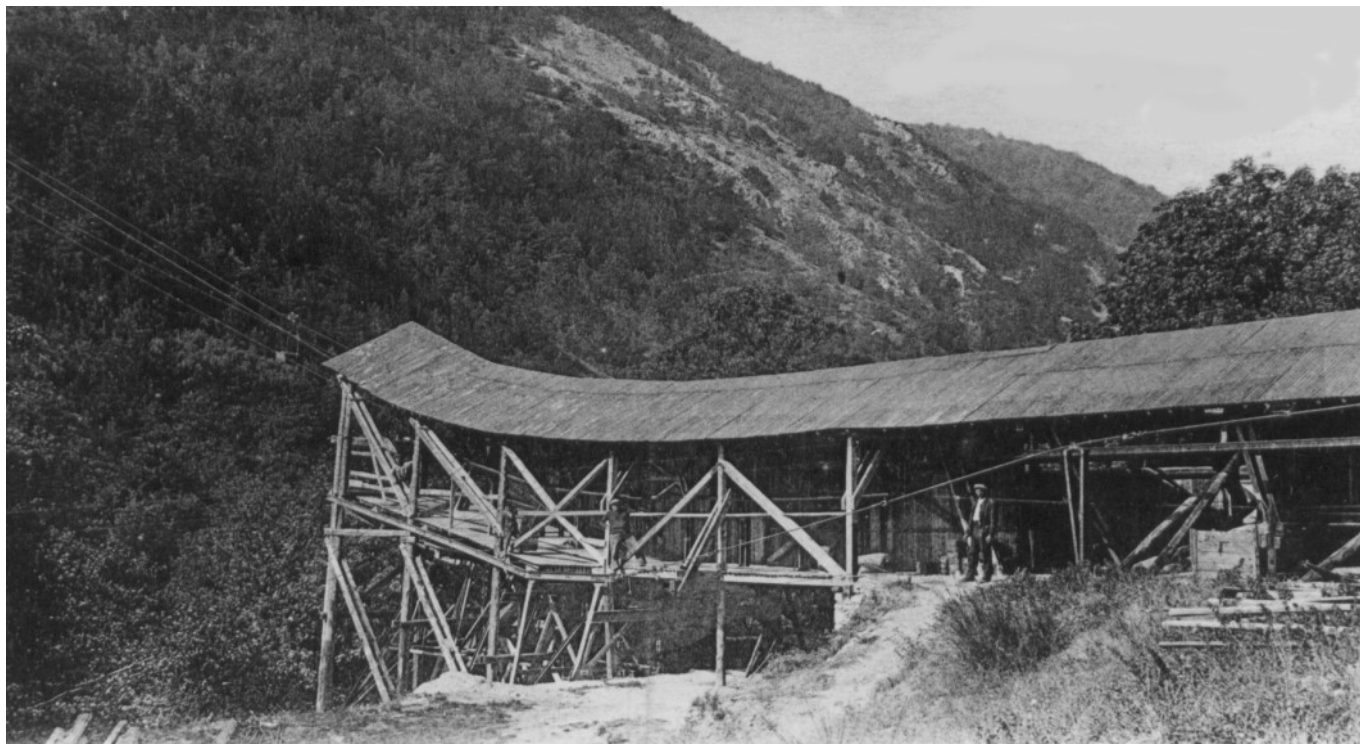
Tunnel de réception du talc, à la "forge haute".
