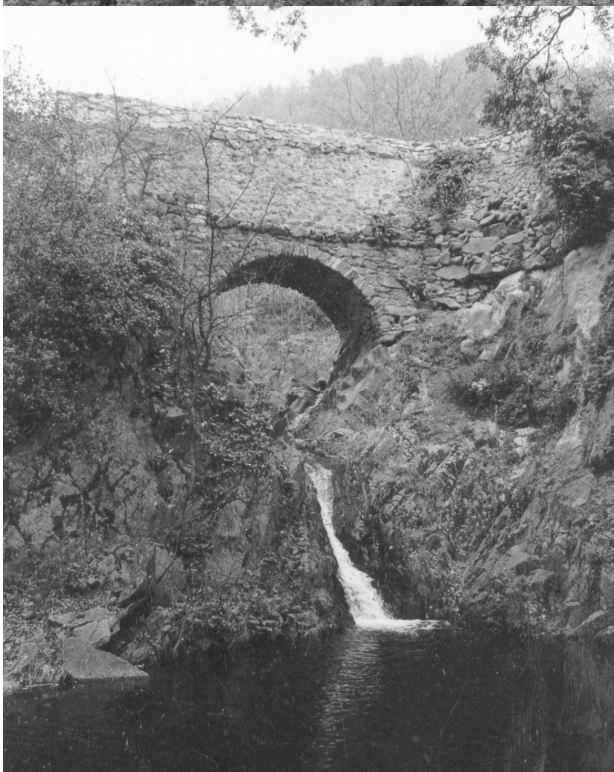
Pont sur le chemin royal de Molitg (ancien chemin de Sournia)
