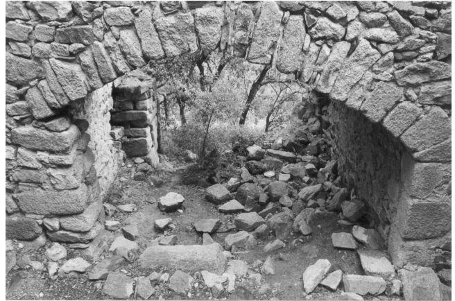
Une arche encore intacte
