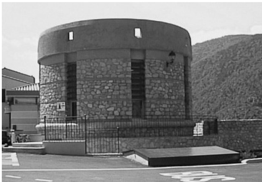
La chaufferie communale de Mosset est sous le Tour des Parfums Au premier plan le silo d'alimentation
