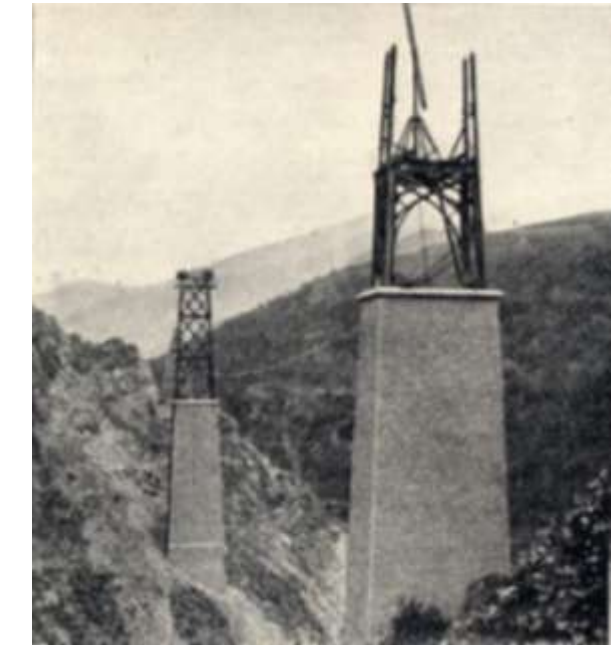
Construction du pont Gisclard
